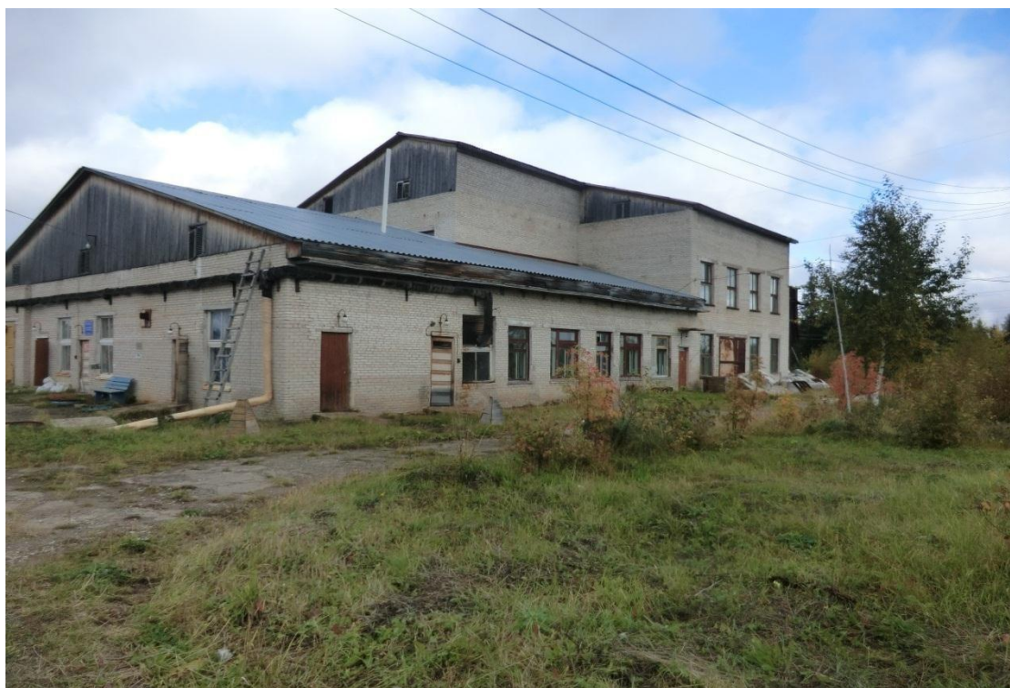
Рис. 3. Водопроводные очистные сооружения.
