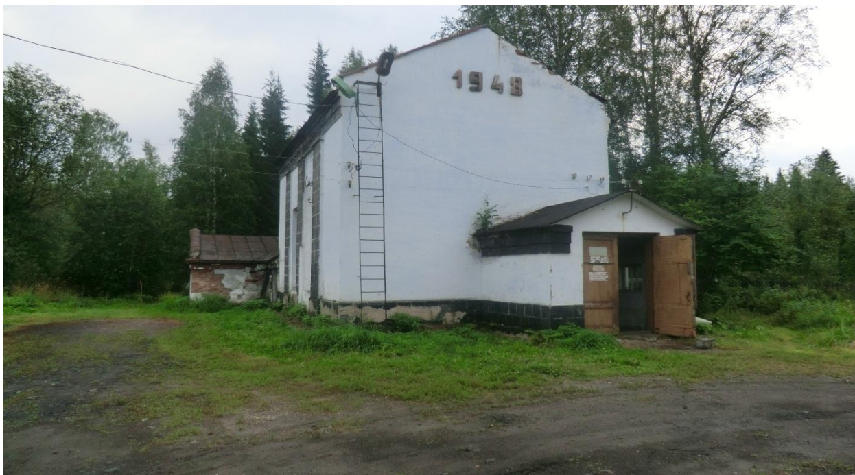
Рис. 2. Береговая водозаборная станция.
